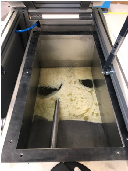
Tank mit Wasser-Öl-Gemisch Tank with a water-tramp oil mixture
